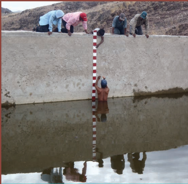
Instalación de una regleta para medir volumen de agua, Wa' eachi.
