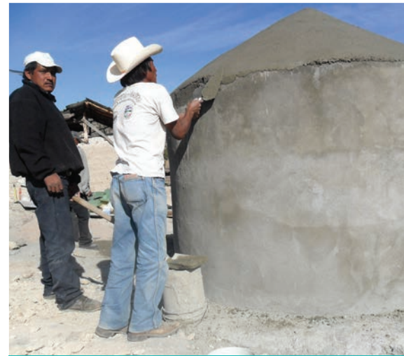
Construcción de una pila de agua, Sitagapachi.
